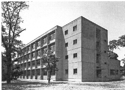
4号館北東面全景（昭和52年3月）
