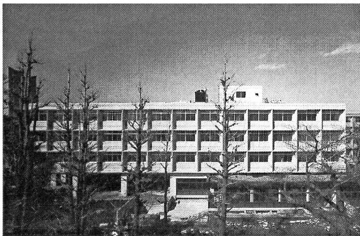
5号館正面外観（『昭和54年度校舎新営工事しゅん功写真』）
