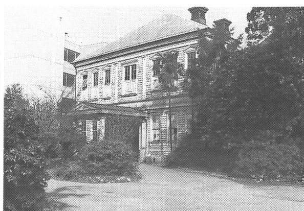
正面入口（右側より見る。左隣は4号館校舎）
